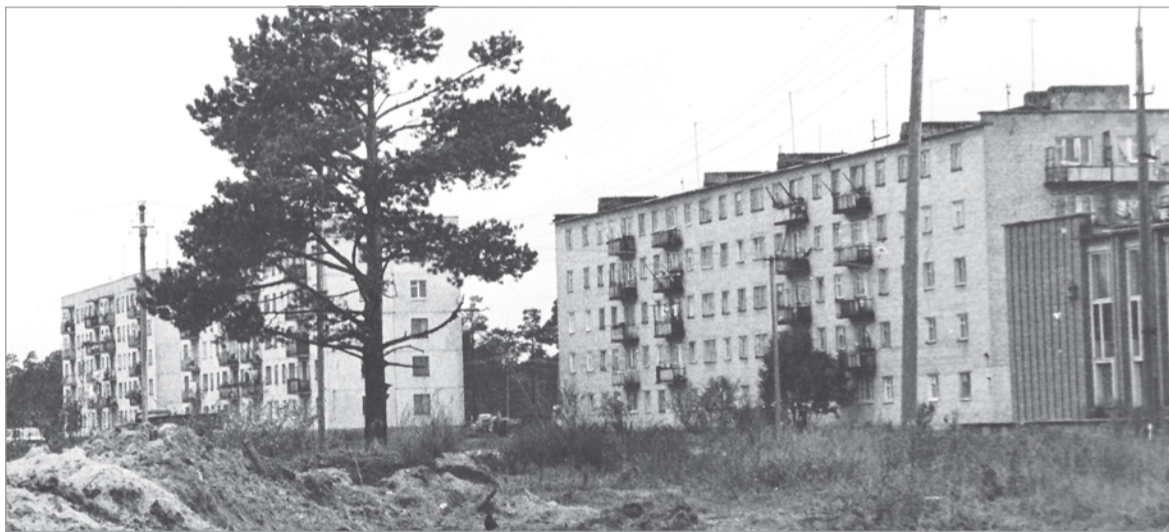
5-этажки строили для работников совхоза «Ильич» (фото из архива редакции, 1990-е годы)
